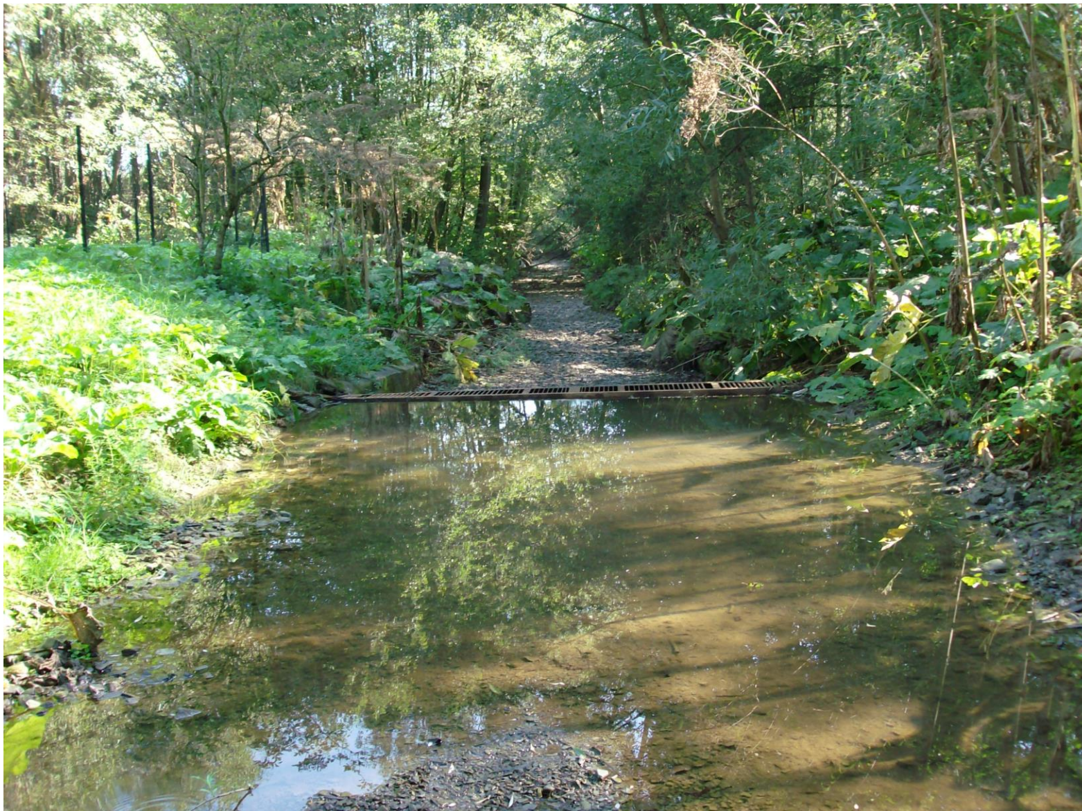
Ujęcie wody na potoku górskim - 31 sierpnia 2015 r.
